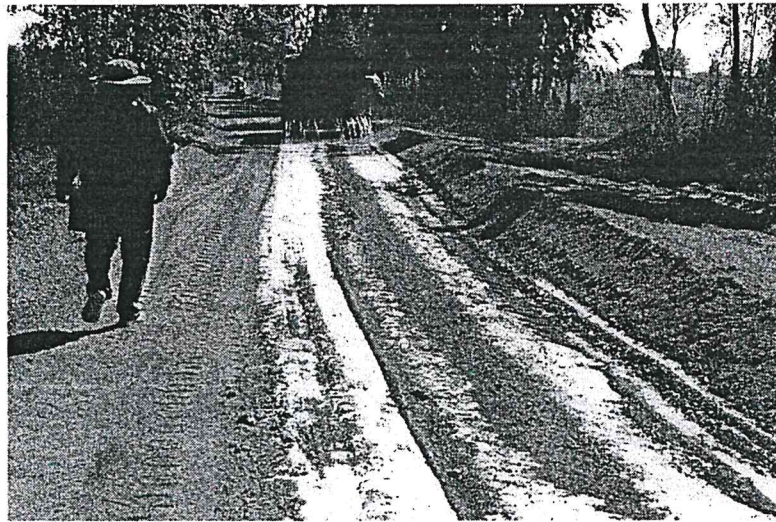
รูปที่ 7 รถน้ำสเปรย์น้ำยางพาราตัดแปรรถเกรตปรับส่วนผสมให้เข้ากัน
