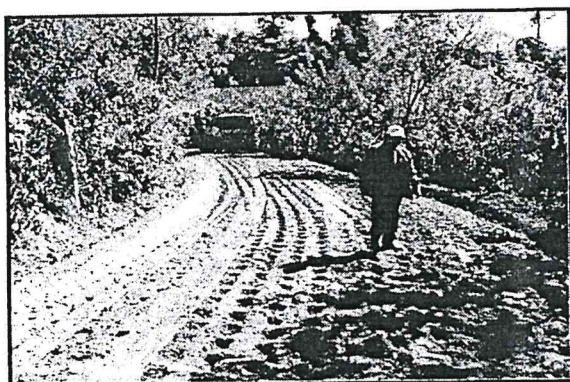
๑.) เตรียมพื้นที่ โดยเกรตเตอร์กรุยดินเดิมขึ้นมา
