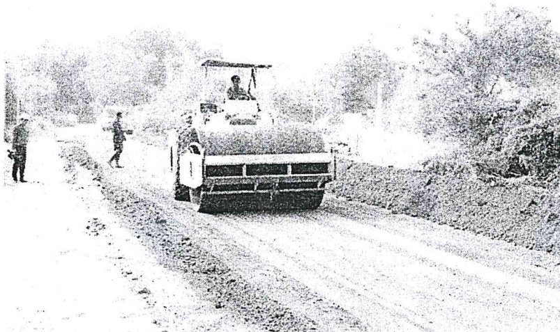
รูปที่ 3 การบดอัดโดยใช้รถบดล้อเหล็ก ขนาดน้ำหนัก 10 ตัน
