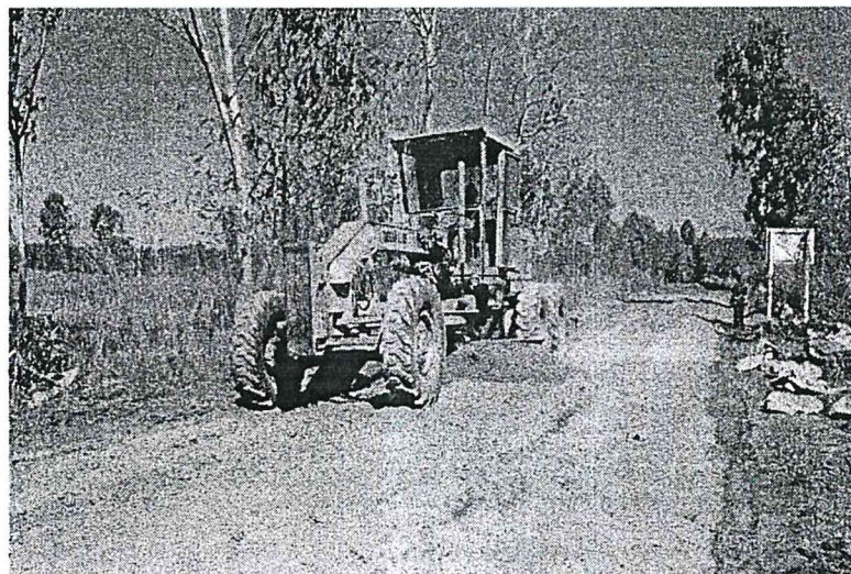
รูปที่ 6 รถเกรดคดกลเค้าส่วนผสมให้เข้ากัน
