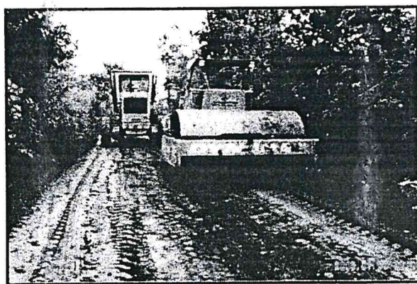
๕.) การบดอัด ให้แน่นโดยรถล้อเหล็ก และรถล้อยาง
